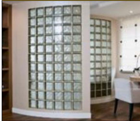
Стеклоблочная перегородка
